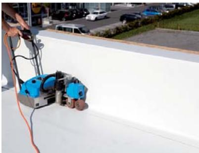
5. Suelde el solape con el equipo adecuado para termosoldadura en caliente
