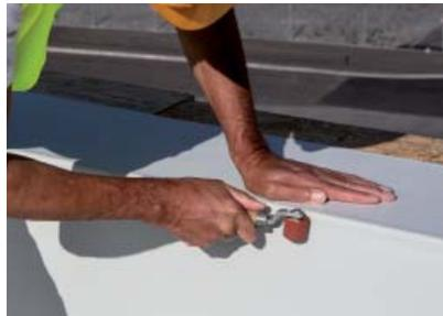
Trabajo de aplicación y detalle fácil y rápido. Cintas y membranas autoadhesivas para detalles y petos.
